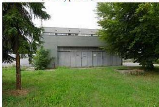
Trafostanice - jihovýchodní pohled
