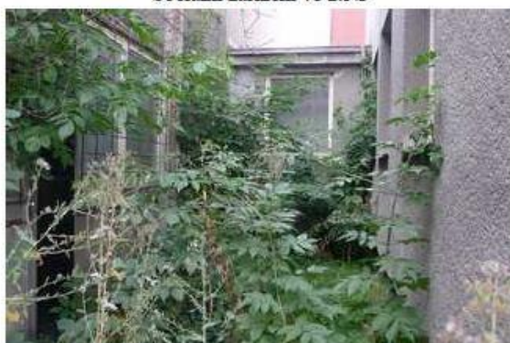
Spojovací krček mezi zdr.střediskem a budovou rehabilitace
