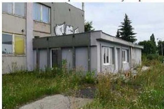
Vrátnice - jihozápadní pohled
