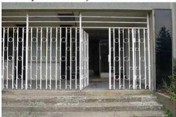
Vstup do zdr.střediska z areálu závodu
