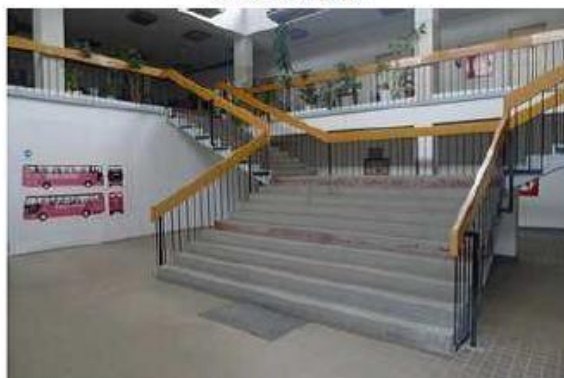
Schodiště do 2.NP
