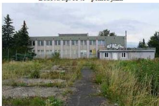
Pohled na budovu č.p. 5345 a vrátnici - jihozápadní
