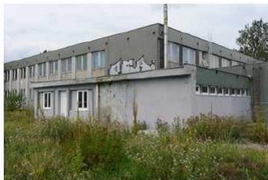
Budova č.p. 5345 - v popředí vrátnice
