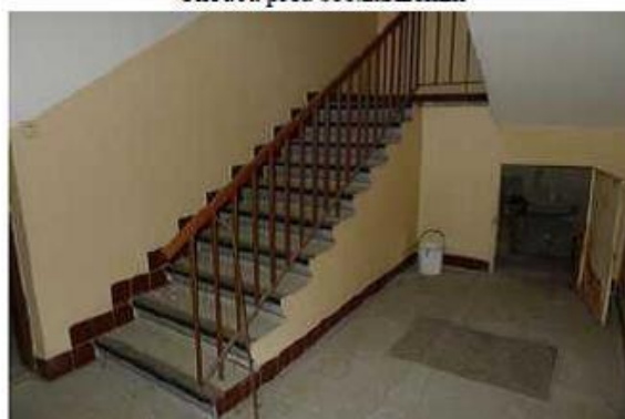
Schodiště do 2.NP
