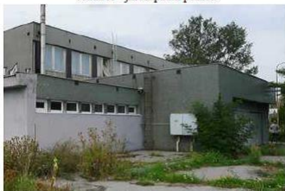
Budova se soc.zařízením, vpravo trafostanice
