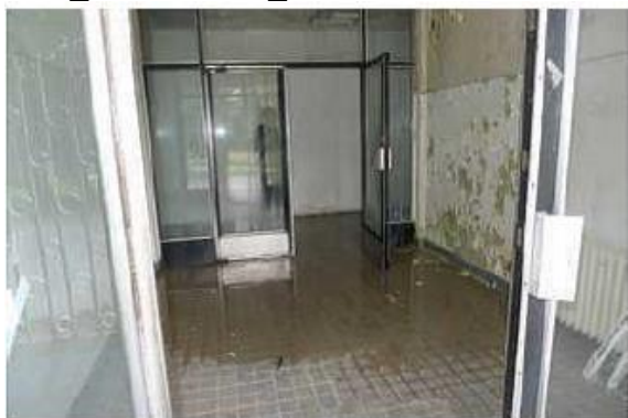
Hlavní vstup s navatující chodbou
