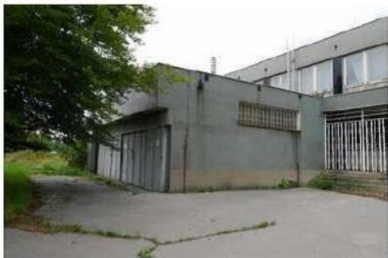
Trafostanice, vpravo vstup do zdr.střediska
