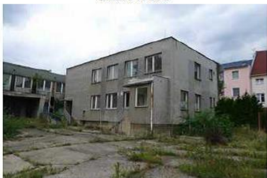
Budova č.p. 5346 rehabilitačního zařízení - pohled z areálu závodu
